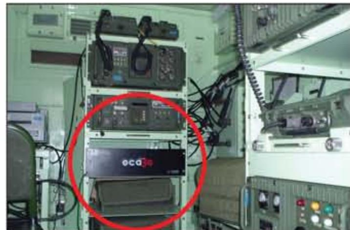
그림-12. 통신차량 통신 Rack에 3세대 접지장치(eca3G) CM Series 설치(2008.12)
