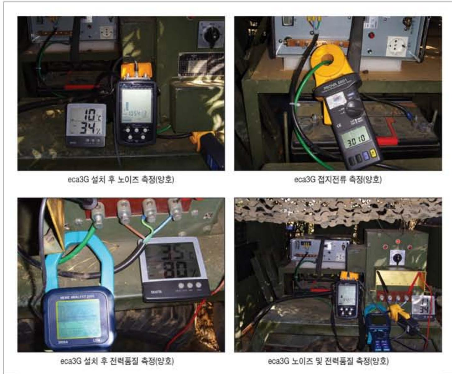
그림-13. eca3G 설치 후 상태 측정
