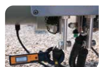
▲ 설치 후 전류 측정
