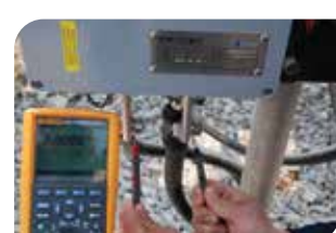
▲ 설치 후 전압 측정
