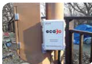
▲ 수방사 외곽경계 CCTV 함체
