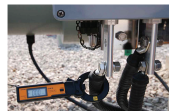
▲ 설치 후 전류 측정
