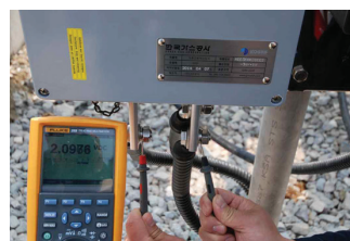
▲ 설치 후 전압 측정
